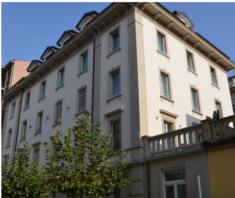
Foto dello stabile in Via Novelli 10/a, 2023
