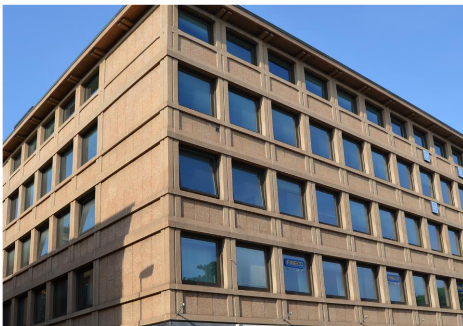
Foto dello stabile in Via Tasca n. 1, 2023
