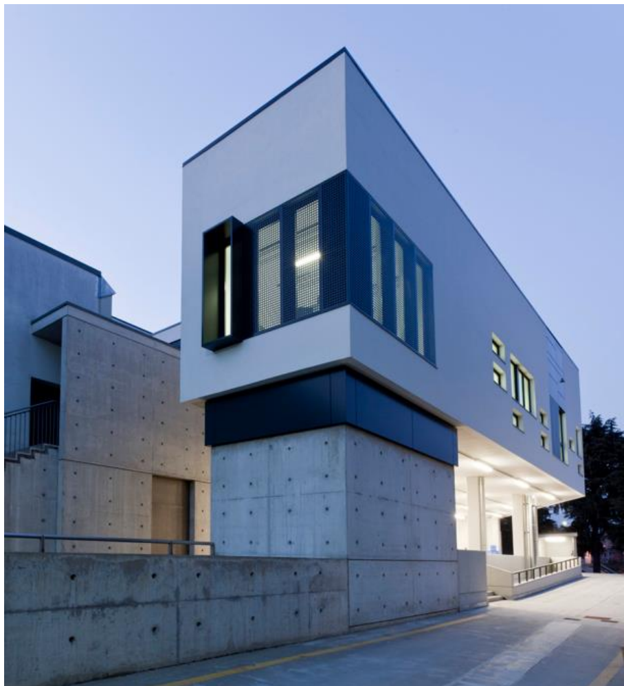
Un'immagine dell'edificio "C", che ospita gli attuali uffici della Cassa Edile a Seriate
